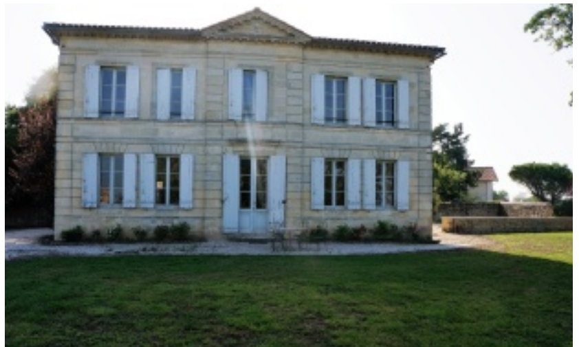
Das Schloss von Pontoise Cabarrus wird renoviert
